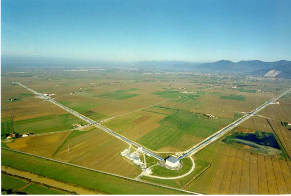
FIG. 6.1 – Vue aérienne du détecteur interférométrique d’ondes gravitationnelles VIRGO, situé à Cascina, près de Pise (Italie). La construction de VIRGO s’est achevée en 2003. Les cavités Fabry-Pérot de chacun des bras de 3 km ont été alignées avec succès et les premières franges d’interférence ont été obtenues en février 2004. Le détecteur est actuellement en phase d’acquisition de données à une sensibilité très proche de sa sensibilité nominale (cf. Fig. 6.5) [source : CNRS / Istituto Nazionale di Fisica Nucleare].
